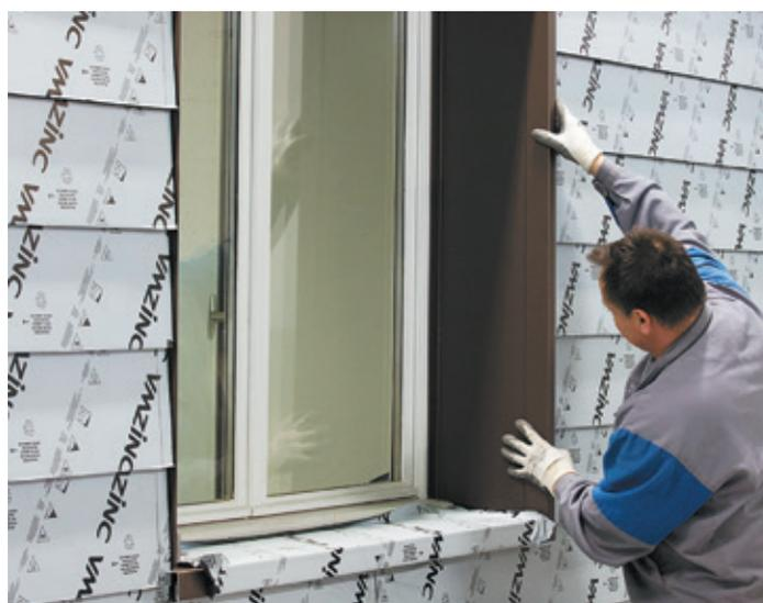
**Sturz** Zuschnitt des Sturzprofils und Einschieben in das Einsteckprofil. Einrasten in die Universalhaften.
