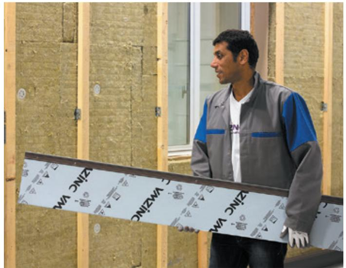
Die Paneele werden von unten nach oben durch Einrasten ineinander verlegt.
