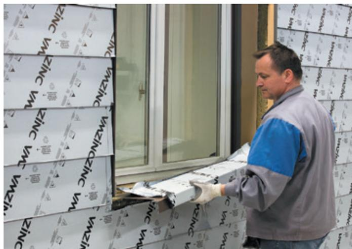
**Laibung** Zuschnitt der Laibungsprofile und Einschieben in die Einsteckprofile. Einrasten in die Universalhaften.
