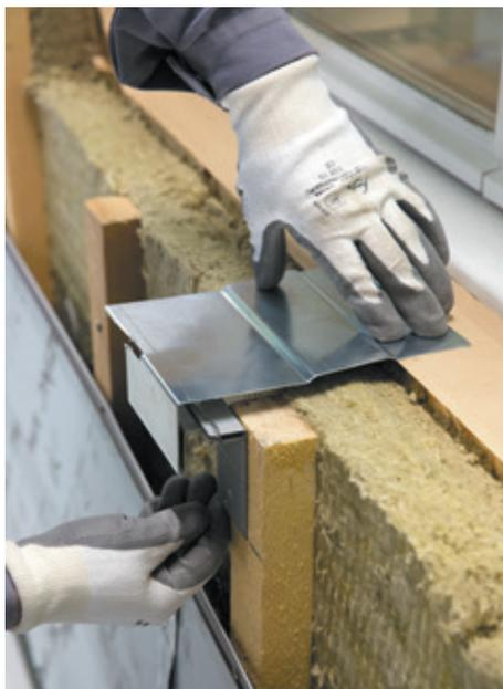
Die Befestigung des letzten Paneels unter der Fensterbank erfolgt über selbstschneidende Schrauben (Durchmesser 4,8 mm, Kopf 12 mm).
